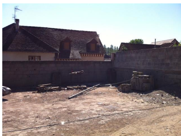
Zone avec dalle en mauvais état
